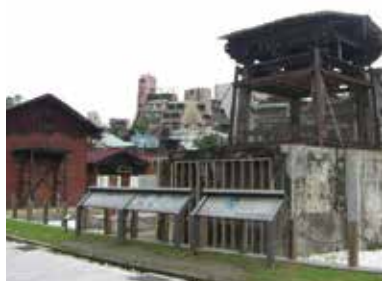
台湾日本統治時代の建物
